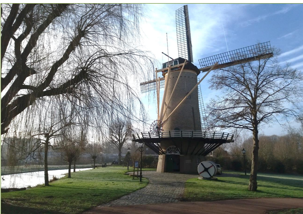
Foto 1: diverse bomen staan erg dicht bij de molen en zijn aanzienlijk hoger dan de toegestane hoogte. De windvang wordt hierdoor aanzienlijk gehinderd.
